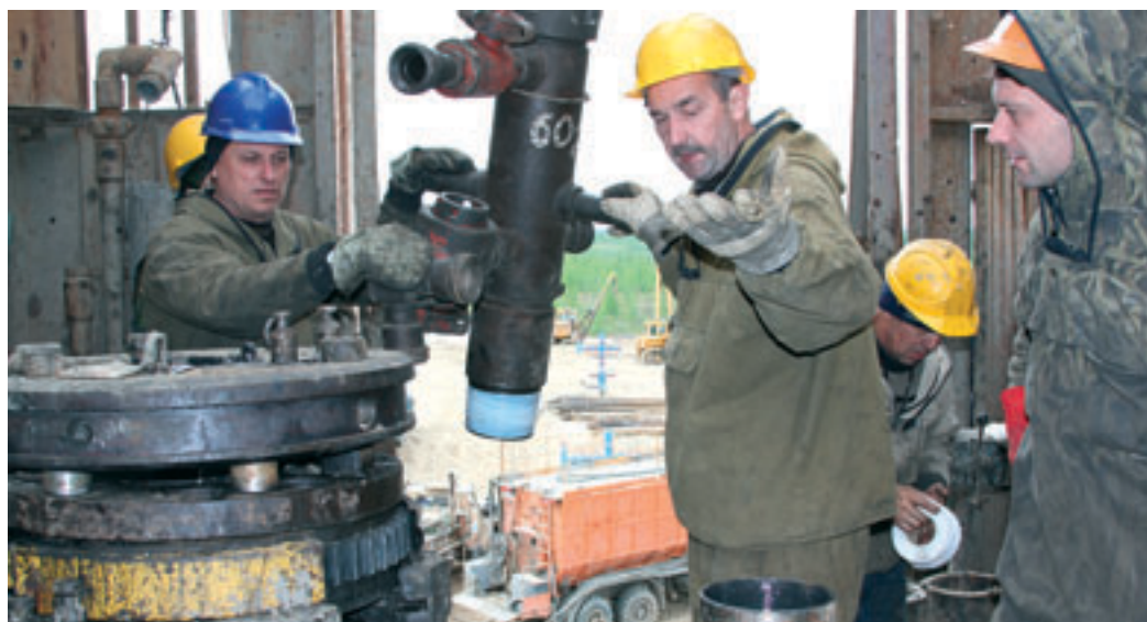
Буровики устанавливают цементировочную головку (фото С. Мильшина).
